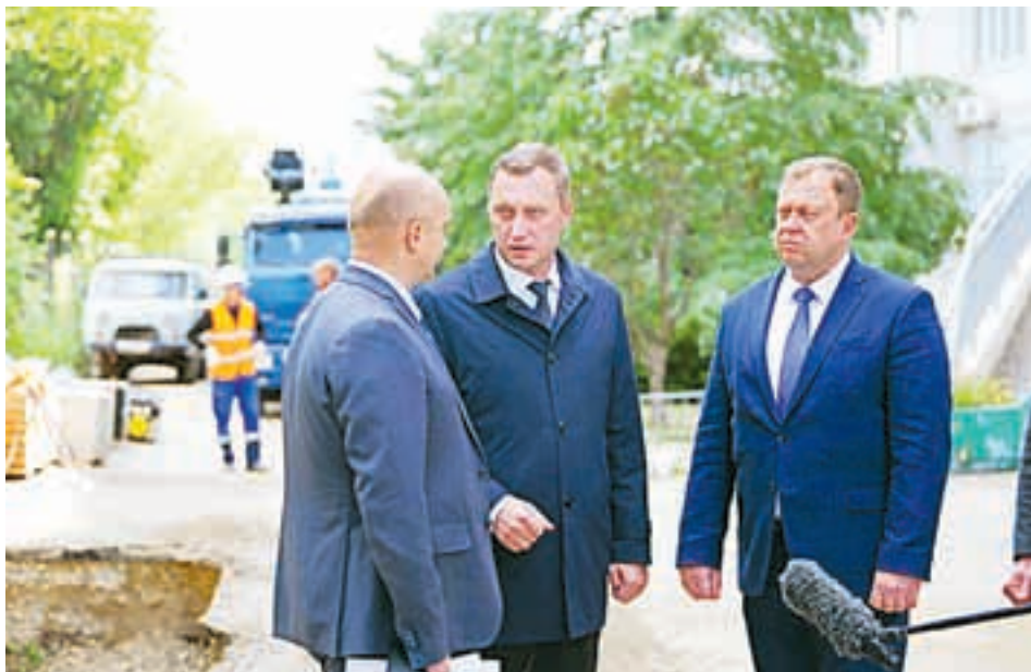
Практически на всех участках полной замены труб и реконструкции не было в среднем больше 40 лет.
