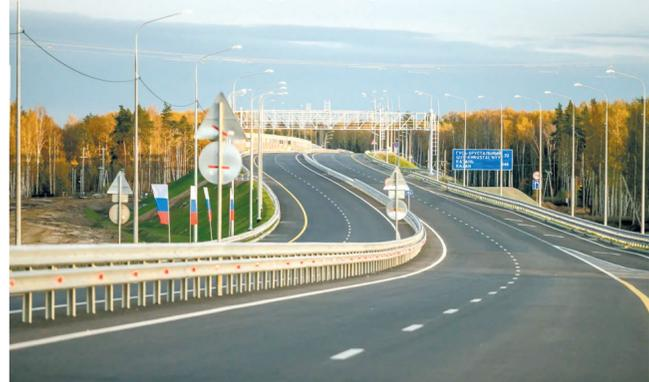
протяженностью более 200 метров и развязки с М-7, Р-132 «Золотое кольцо» можно назвать самыми сложными искусственными сооружениями этого этапа. Развязка на М-7 выполнена как неполный клеверный лист, с путепроводом тоннельного типа, а с Р-132 — в виде двух разворотных колец, которые примыкают к «Золотому кольцу».
