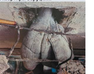
Заблокированный ватным одеялом вентиляционный канал.
