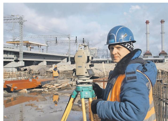
16 февраля 2019 года 11:09 Монтажник Богдан Мельничский устанавливает теодолит (геодезический инструмент) для замеров на строящейся Некрасовской линии метро
